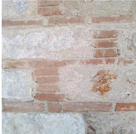
FIG. 287. PARTICOLARE DI MURATURA IN OPERA LISTATA.
