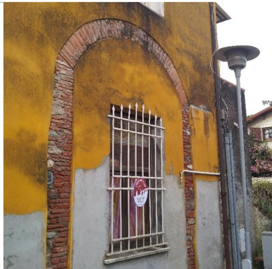
FIG. 68. COLORITURA PARZIALE E NON CONFORME ALLA TIPOLOGIA ARCHITETTONICA.
