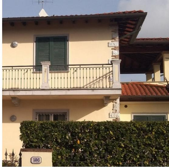
FIG. 64. RIVESTIMENTO CON FINTO CANTONALE IN OPERA LISTATA.
